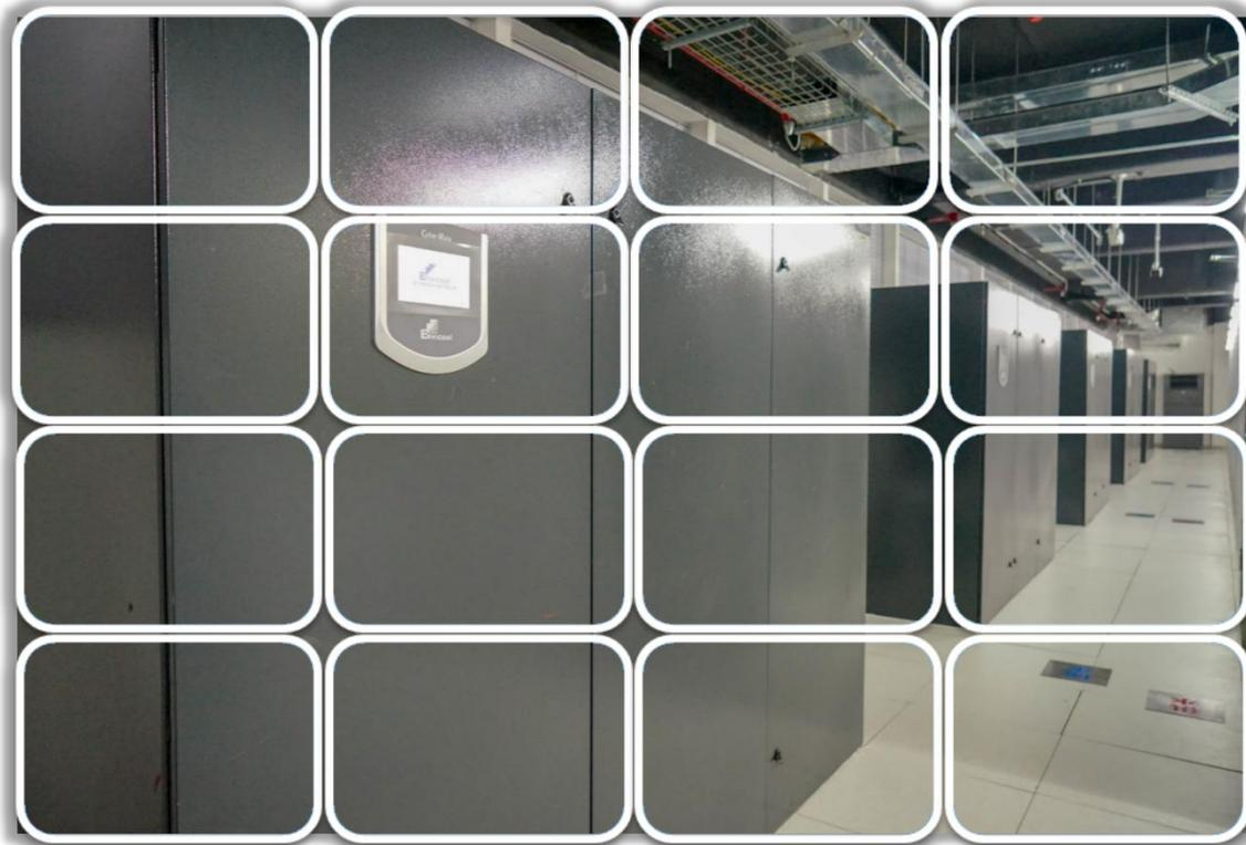
数据中心使用英维克精密空调，采用N+1结构设计
